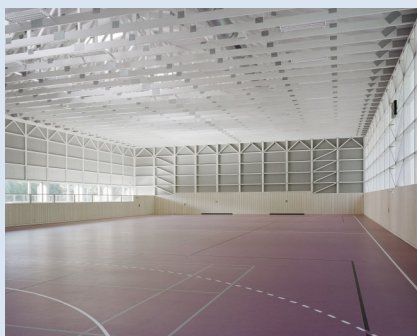
Turnhalle Haiming in NP-Bauweise
